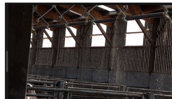
Raccordés à l'unité de transfert, les tuyaux percés depuis lesquels la paille s'écoule. DR
