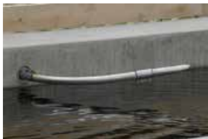
Point d'alimentation mural démontable sans outil
